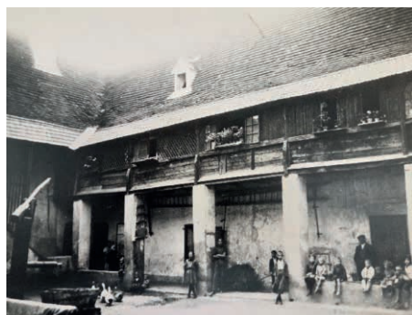
Ehemaliger Innenhof des Gebäudes 1924
